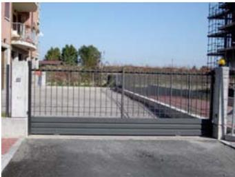
Il cancello dell'accesso carraio, realizzato come sopra, con apertura del tipo scorrevole in un'unica anta sarà completo di motorizzazione elettrica con comando a distanza (1 ogni alloggio).
