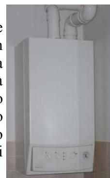
La caldaia del tipo a doppio uso, produrrà l'acqua calda per le apparecchiature sanitarie.
