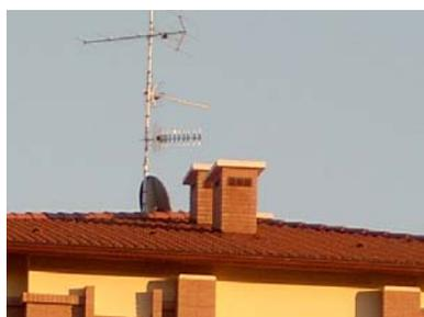
L'impianto di ricezione TV è unico per tutto il complesso ed è costituito da un'antenna centralizzata per la ricezione dei canali RAI e di 5 canali privati, con predisposizione del centralino per aggiunta di ulteriori canali privati.
