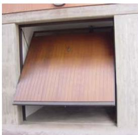
Le autorimesse saranno dotate di una porta basculante a contrappesi composta internamente da montanti e traversi in ferro verniciato, rivestita esternamente con un pannello in okumè multistrato pantografato a doghe verticali e completa di serratura Yale.
