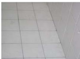
Tutti i locali della zona giorno saranno pavimentati con mattonelle di ceramica monocottura di prima scelta nel formato di cm. 30x30, o similare, del prezzo netto di acquisto di € 9,30 il m<sup>2</sup>, posati a correre con fughe accostate.
